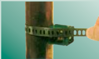
Cortar la correa de fijación
