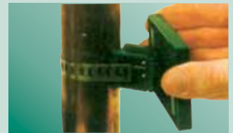
Fijar el soporte al espaciador
