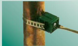
Fijar el espaciador a la tubería
