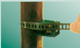
Cortar la correa de fijación
